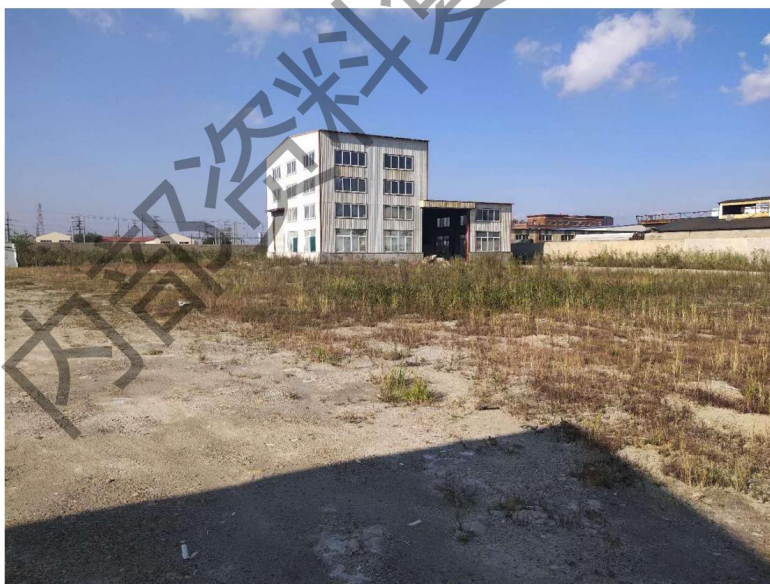
图 3-4 地块东北侧临时彩钢建筑物
