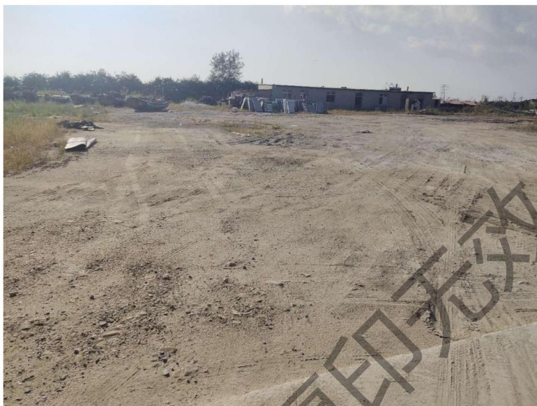
图 3-3 地块西侧临时瓦房建筑物
